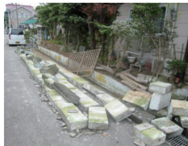
倒壊した石塀
