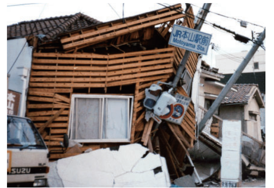
1995年阪神淡路大震災における建物被害
